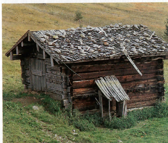
Bellamonte: cessato l'utilizzo agricolo, la rovina delle antiche baite incomincia dal tetto (foto Arturo Boninsegna).
