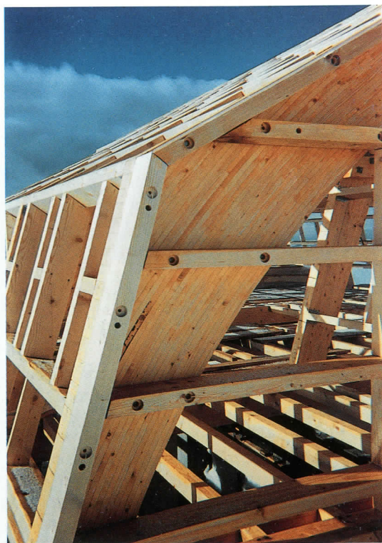
Un particolare della struttura portante del nuovo rifugio del Vidòz (foto Carlo Sebastiani).
