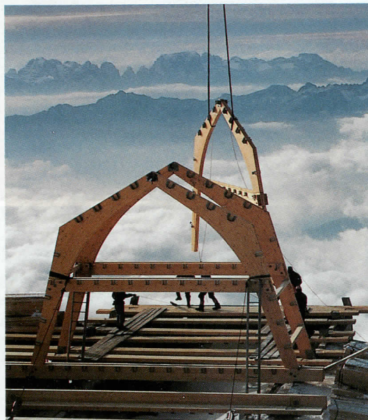
La posa degli archi in legno lamellare che costituiscono la struttura portante del nuovo rifugio (foto Carlo Sebastiani).
